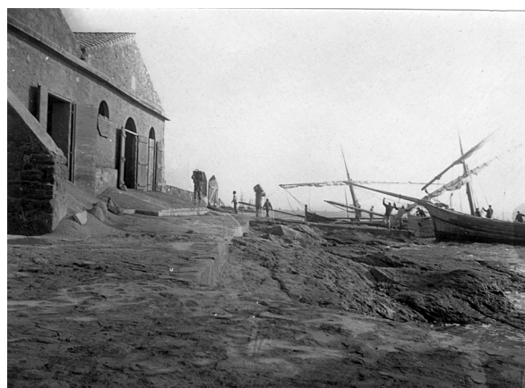
Figura 8: Carloforte, Magazzini della Vieille Montagne. Scarico delle bilancelle.
